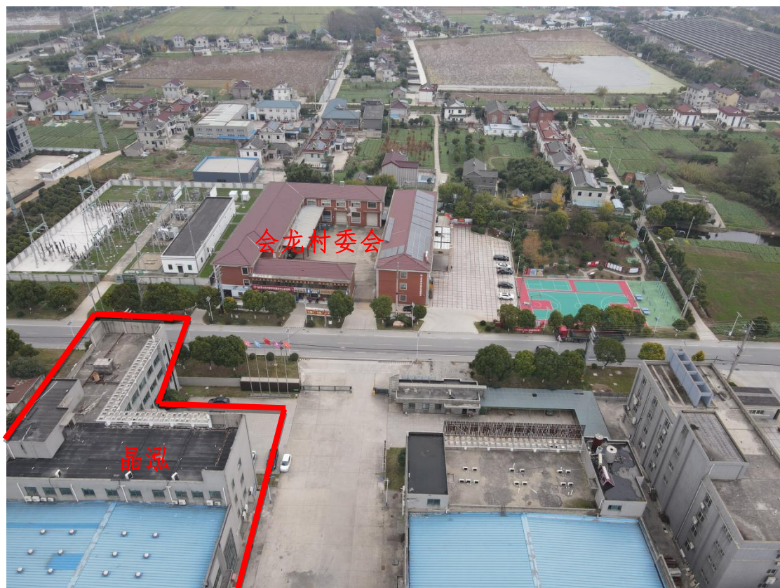
图 2.3-1 航拍图-东（2022 年 12 月 16 日）
